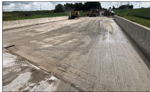
(d) Deck surface after completion of milling
